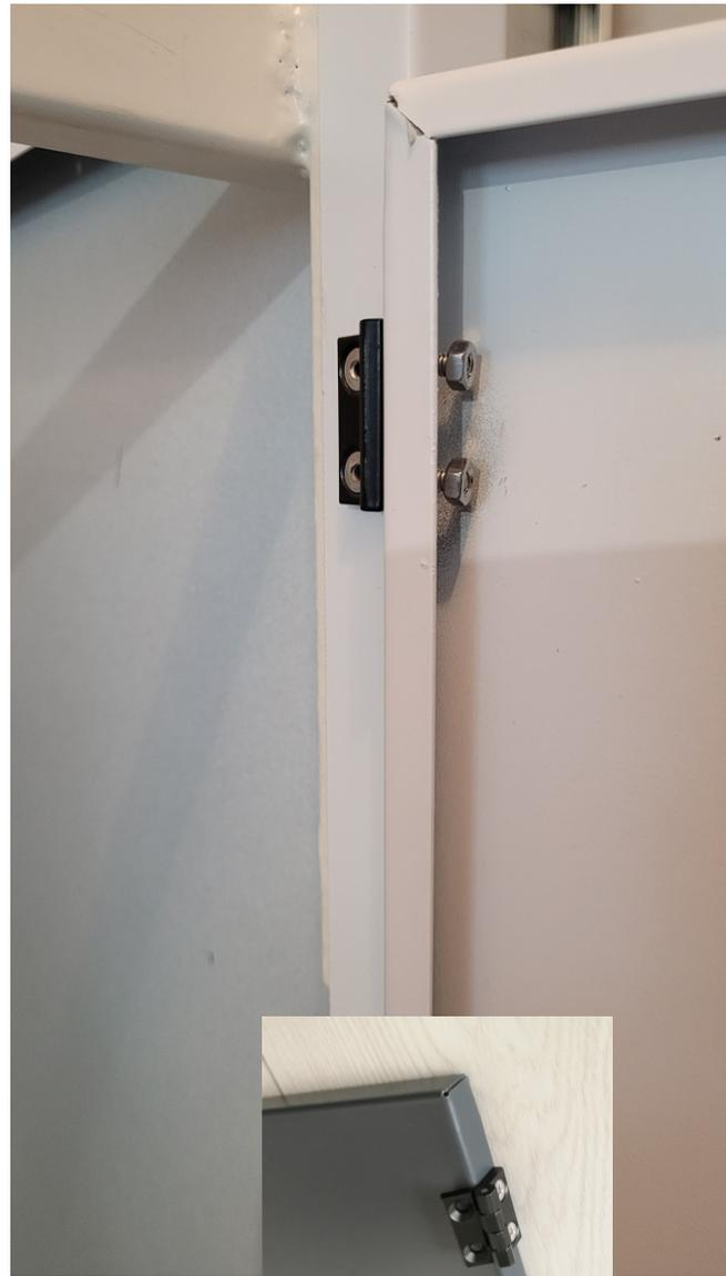
Die **Tür** an den Scharnieren mit den Schrauben und einer Mutter von Hintern montieren.
