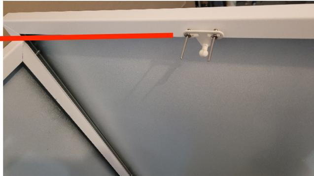
Die Dämpferaufnahmen an den Seitenwänden bitte mit einer Niete befestigen
